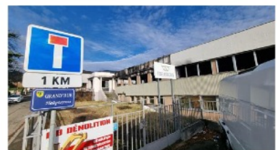
La partie où se trouvent les anciens bureaux et l'usine constitue les tranches 2 et 3 du projet. Tous les bâtiments en seront rasés. Photo Grégoire Gauchet
